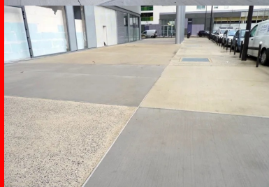
Partie piétonne de la place du Général-de-Gaulle. Un important calepinage a dessiné de grandes transversales et assuré une disposition équilibrée des joints de dilatation – couverts et non recouverts – et de retrait.
