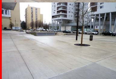
Trois types de bétons ont été retenus pour le revêtement de la place du Général-de-Gaulle : un béton brossé pour les zones piétonnes, un béton bouchardé, permettant le passage occasionnel de gros véhicules, et un béton hydrogommé pour la partie circulée de l'espace.
