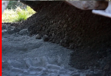
Traitement du sol
