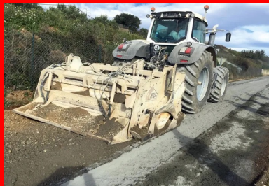
En action sur le chemin du Bousquet, en octobre 2015, le « tracteur muni d'un malaxeur » loué à la société nimoise Ecostab, spécialisée dans le traitement des sols.
