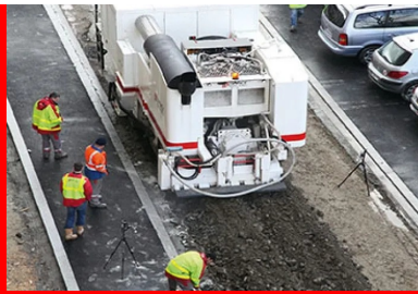
L'atelier de retraitement ARC® 1000 en action dans le quartier des Sapins à Rouen. Il s'agit de sa première utilisation en zone urbaine.
