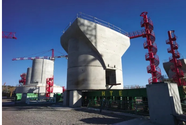
Les têtes de piles les plus lourdes pèsent jusqu'à 2 000 t.
