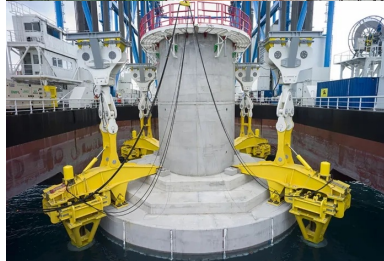
Les embases de 4 500 t sont posées avec une précision de 35 mm grâce à la barge zourite.
