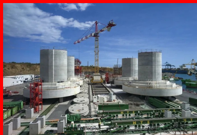
Les semelles de fondation cylindriques des embases de piles sont très massives : de 20 à 23 m de diamètre pour 4 m d'épaisseur.
