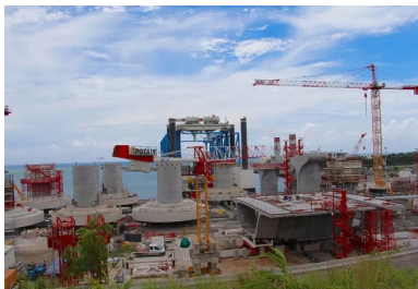
Une fois leur phase de maturation terminée, les embases et têtes de piles sont embarquées directement depuis l'aire de préfabrication sur la barge (au fond en bleu) qui les mettra en place.
