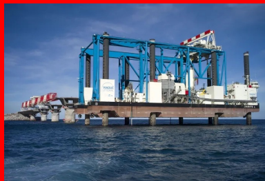
Zourite, la plate-forme automotrice, peut se stabiliser en se hissant sur ses 8 jambes d'acier. Les éléments de piles peuvent alors être installés dans des conditions équivalentes à celles de la terre ferme.
