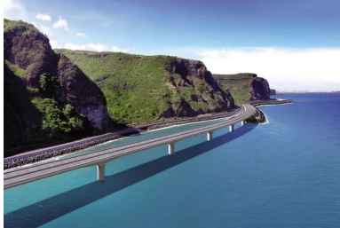
Long de 5,4 km, le viaduc forme des travées de 120 m et repose sur 48 piles en mer.
