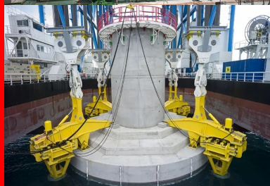
Les embases de 4 500 t sont posées avec une précision de 35 mm grâce à la barge zourite.
