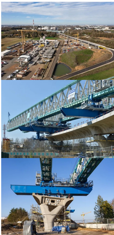
Tous les voussoirs sont préfabriqués dans une aire dédiée de 4,5 ha. Après maturation, les voussoirs sont acheminés jusqu'à leur lieu de pose en empruntant les parties de l'ouvrage déjà construites.
