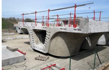
Chacun des voussoirs possède des caractéristiques et une géométrie uniques.
