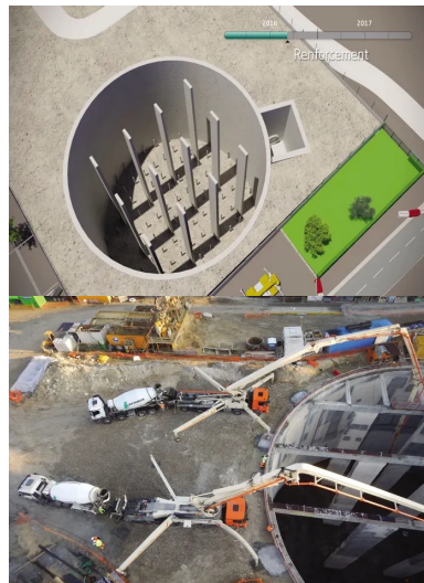
Avec 25 m de profondeur et 40 m de diamètre, la capacité du bassin est de 23 400 m 3 .
