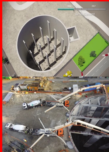
Avec 25 m de profondeur et 40 m de diamètre, la capacité du bassin est de 23 400 m 3 .
