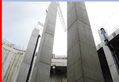
Les poteaux de 25 m de hauteur à l'intérieur du bassin de stockage.
