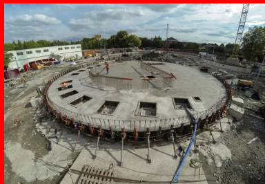
La dalle de couverture de la station.
