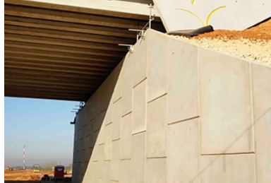
17 ouvrages, dont le pont-route de la rd 42 à Caissargues (gard), font appel à la technique sur appuis voûte. Les escaliers en béton armé constituent le parement.
