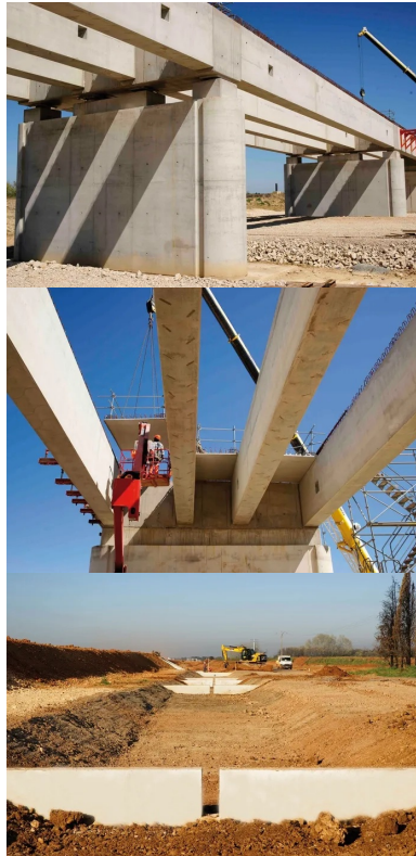
Les estacades sont constituées de poutres préfabriquées en béton armé reposant sur les piles.
