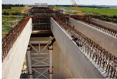
Long au total de 345 m, le viaduc du Vistre comporte un ouvrage droit de 261 m de type quadripoutres en béton armé.
