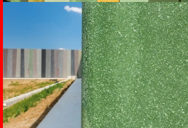
Gros plan sur le revêtement en « peau de sirène » des parements de béton.
