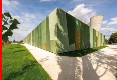
Parement cubiste en béton scintillant revêtu de millions de microbilles.
