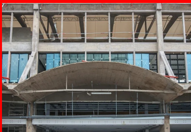
La légèreté de la structure est due aux auvents suspendus et stabilisés par des tirants métalliques noyés dans le béton.
