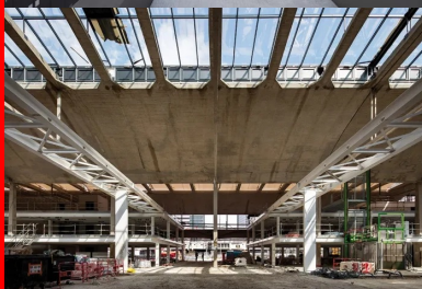
La halle est constituée de minces voûtes en béton (5 cm au faîtage) supportées par de fins piliers pyramidaux.
