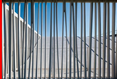
L'unité de post-dénitrification des eaux est desservie par une grande faille organisée entre les bassins de traitement et les locaux techniques intégrés sous une terrasse-jardin, une création originale de coques structurelles précontraintes et de ses résilles à base de BFUP se développe en couverture et en façade des bassins de traitement.
