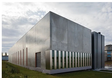
Unité de traitement des boues.
