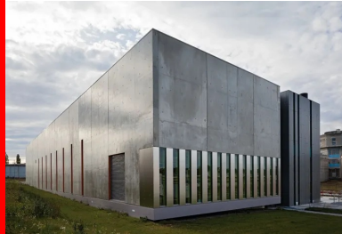
Unité de traitement des boues.
