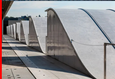
L'unité de post-dénitrification des eaux est desservie par une grande faille organisée entre les bassins de traitement et les locaux techniques intégrés sous une terrasse-jardin, une création originale de coques structurelles précontraintes et de ses résilles à base de BFUP se développe en couverture et en façade des bassins de traitement.
