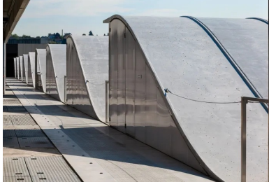
L'unité de post-dénitrification des eaux est desservie par une grande faille organisée entre les bassins de traitement et les locaux techniques intégrés sous une terrasse-jardin. une création originale de coques structurelles précontraintes et de nes résilles à base de BFUP se développe en couverture et en façade des bassins de traitement.
