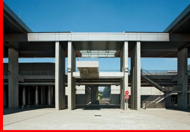
Unité de traitement des pollutions azotées, dite de nitrification.
