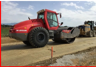
Retraitement des chaussées en place aux lants hydrauliques routiers
