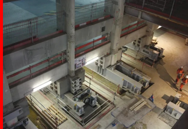
C'est par la « faille » que seront évacués les 150 000 m 3 de terre excavée lors du terrassement en taupe de la gare.
