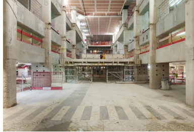
Pour permettre l'accès au chantier, une « faille » de 90 m de long, 10 m de large et 20 m de profondeur a été découpée dans les dalles des parkings existants.
