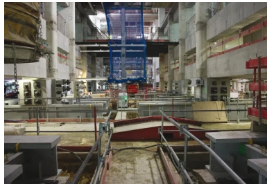
Les 119 poteaux existants sont repris en sous-œuvre afin de pouvoir construire la gare souterraine.
