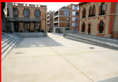
Le revêtement du parvis a été réalisé en Artificio® Bouchardé (PSP 350 kg CE2.5 N CE CP1 NF D10 S3).
