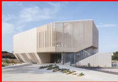
Pour renforcer l'image d'un cristal de roche équerri, le bâtiment a été réalisé avec comme unique matériau le béton.
