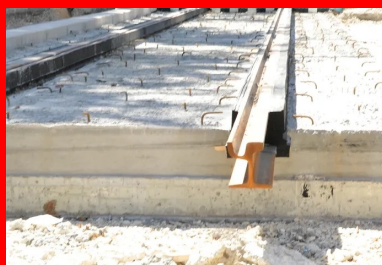
Un rail enrobé dans son complexe en caoutchouc (« jaquette »). Après coulage du béton de calage (vue des connecteurs en surface), en attente du coulage du béton de revêtement.
