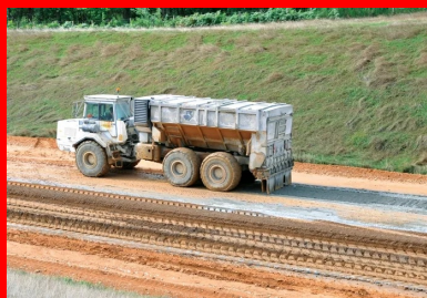
En quatre jours, 800 tonnes de liants Reliac Flex de Lafarge, provenant de l'usine d'Angoulême, ont été mises en œuvre.
