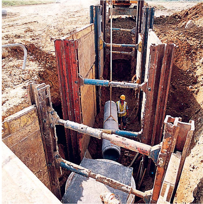
Tranchée Pose de tuyaux d'assainissement en béton dans une tranchée blindée
