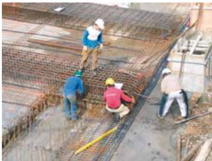
Pose d'armature sur chantier.
