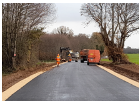
▲ Réalisation des fossés latéraux. (©Ludovic Padeloup/Conseil départemental de la Vienne)
