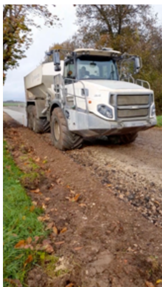
▲ Epandage du liant Ligex M10 à raison de 35 kg/m 2 (dosage 5%) à l'aide d'un épandeur moderne doté d'un système de dosage volumétrique asservi à la vitesse d'avancement. (©Ludovic Padeloup/Conseil départemental de la Vienne)
