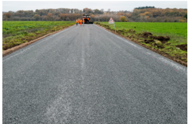
▲ Mise en œuvre de la couche de surface en EB10. (©Ludovic Padeloup/Conseil départemental de la Vienne)
