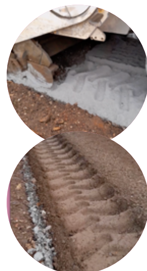
▲ Malaxage du matériau de l'ancienne chaussée avec le liant Ligex M10 sur une profondeur de 35 cm à l'aide d'un pulvimixeur moderne Wirtgen WR240i, permettant d'obtenir un matériau homogène sur toute l'épaisseur et sur toute la largeur de la nouvelle chaussée. (©Ludovic Padeloup/Conseil départemental de la Vienne)
