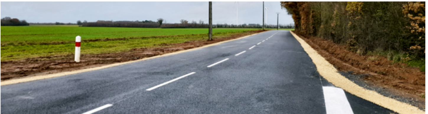
▲ Le tronçon rénové de la RD7 a reçu un nouveau tapis d'enrobés (EB10 sur 6 cm d'épaisseur), avant d'être rouvert à la circulation le 16 décembre 2022. (©Ludovic Padeloup/Conseil départemental de la Vienne)
