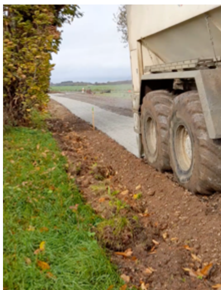
▲ Epandage du liant Ligex M10 à raison de 35 kg/m 2 (dosage 5%) à l'aide d'un épandeur moderne doté d'un système de dosage volumétrique asservi à la vitesse d'avancement. (©Ludovic Padeloup/Conseil départemental de la Vienne)
