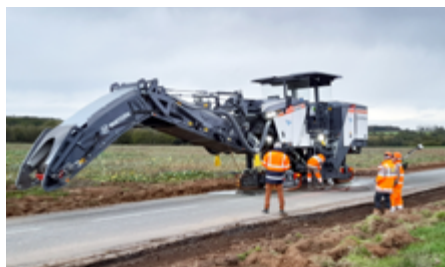
▲ Fragmentation de l'ancienne chaussée sur 15 cm et régalage du matériau décohesionné sur toute la largeur de la nouvelle plate-forme de chaussée. (©Ludovic Padeloup/Conseil départemental de la Vienne)
