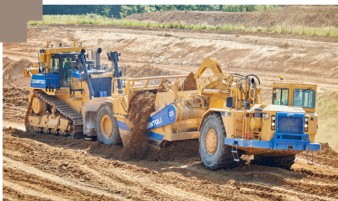
De gauche à droite ↑ Extraction et transport des matériaux à l'aide de scrapers poussés par des bulldozers et stockage provisoire des déblais. ↑ Reprise des déblais sur stock à l'aide d'une pelle sur chenilles et de tombereaux articulés. (© Guintoli – NGE)
