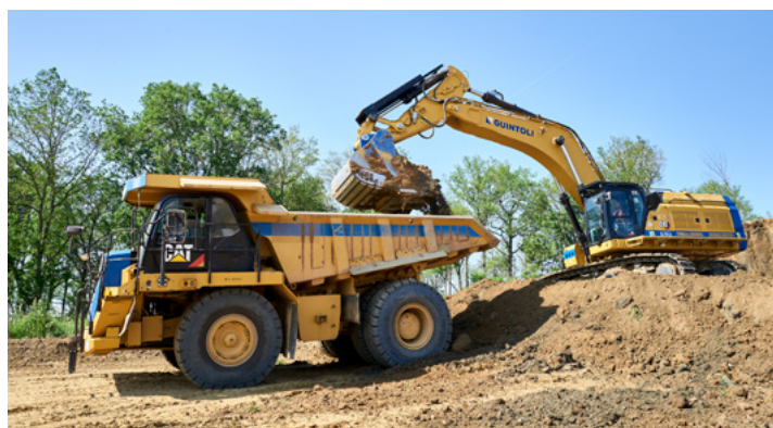
De gauche à droite ↑ Extraction et transport des matériaux à l'aide de scrapers poussés par des bulldozers et stockage provisoire des déblais. ↑ Reprise des déblais sur stock à l'aide d'une pelle sur chenilles et de tombereaux articulés. (© Guintoli – NGE)
