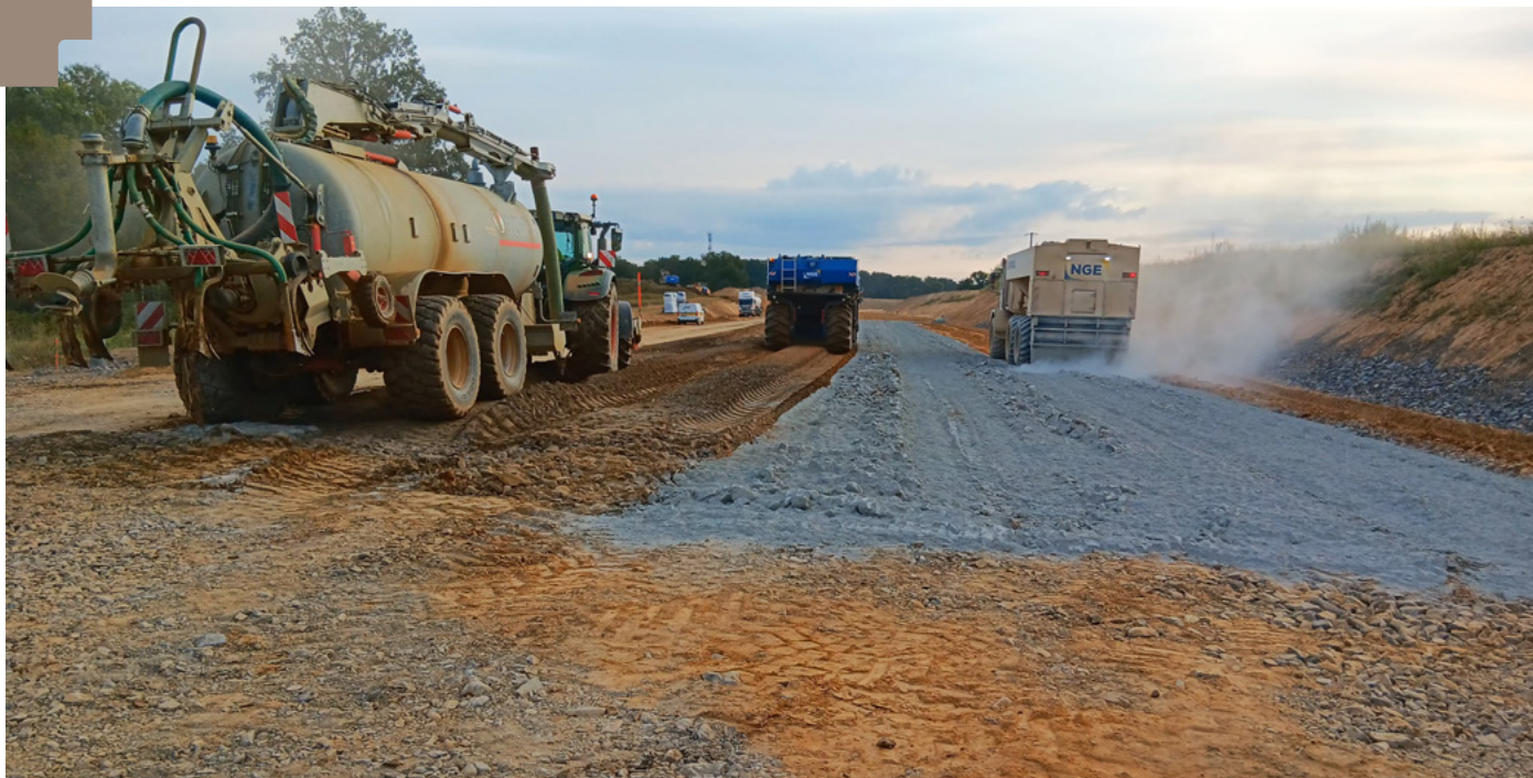
↑ Épandage du LHR Rolac Premier ECOPlanet à la surface du matériau à l'aide d'un épandeur asservi avec contrôle pondéral. © Guintoli – NGE)
