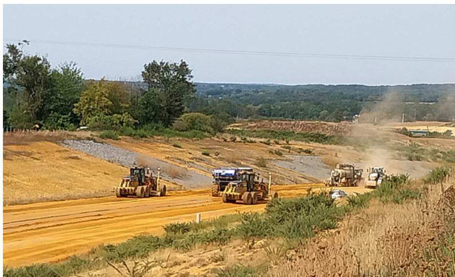
↑ Vue générale du chantier de terrassement, conçu en circuit fermé déblais-remblais. (© Guintoli – NGE)
