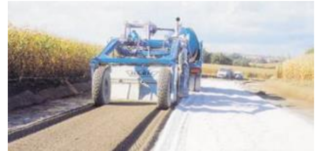
Malaxage en place
