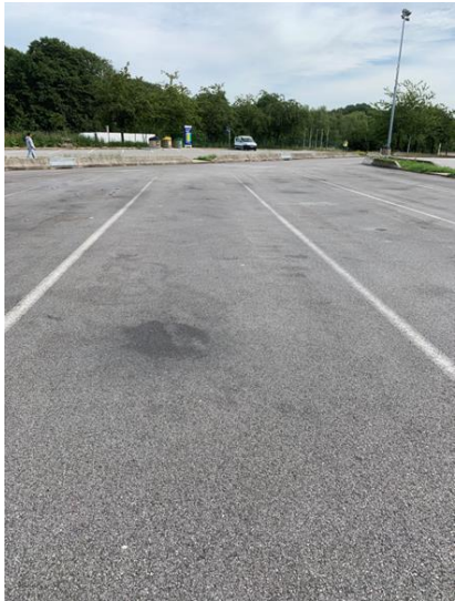
Aire de repos Saint Arnoult A10 - Enrobé orniéré et aménagement en Béton
