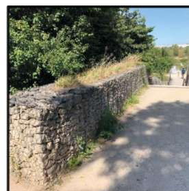
Les murs en gabion
