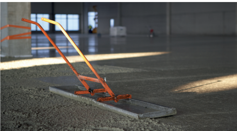
22. Béton damé à l'aide d'une lissarde (crédit SOREDAL)
