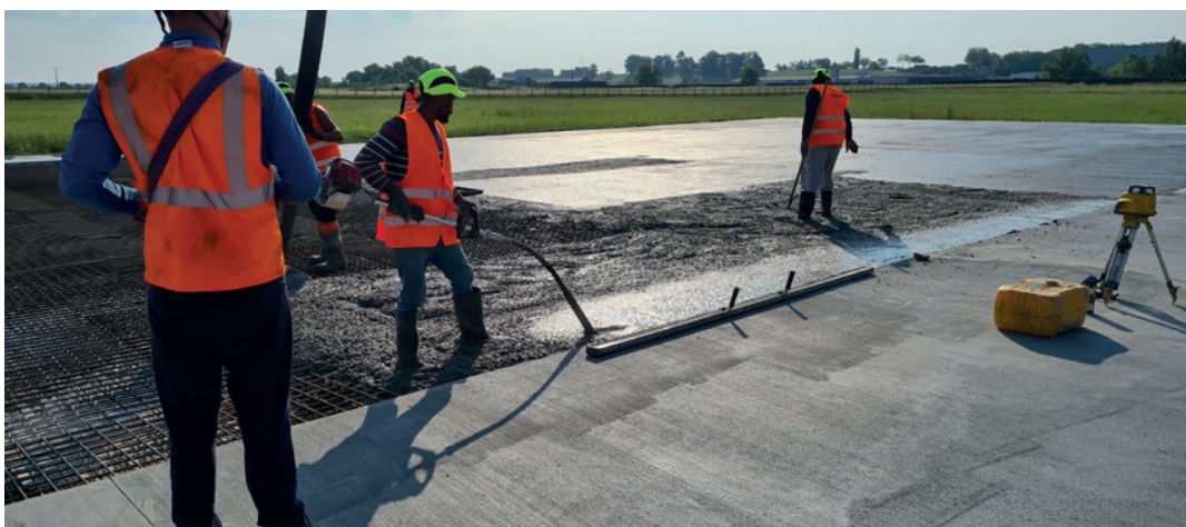
32. Joint d'arrêt de coulage goujonné et vibration du béton - (crédit SOREDAL)
