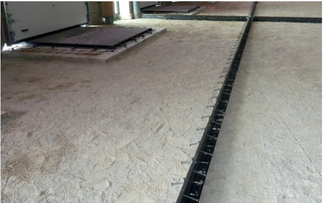
10. Couche de glissement - (crédit SOREDAL)
