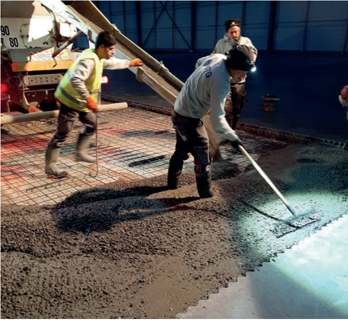
20. Déversement au camion malaxeur et nivellement du béton - (crédit BIG)
