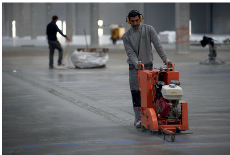
36. Sciage des joints de retrait - (crédit SOREDAL)
