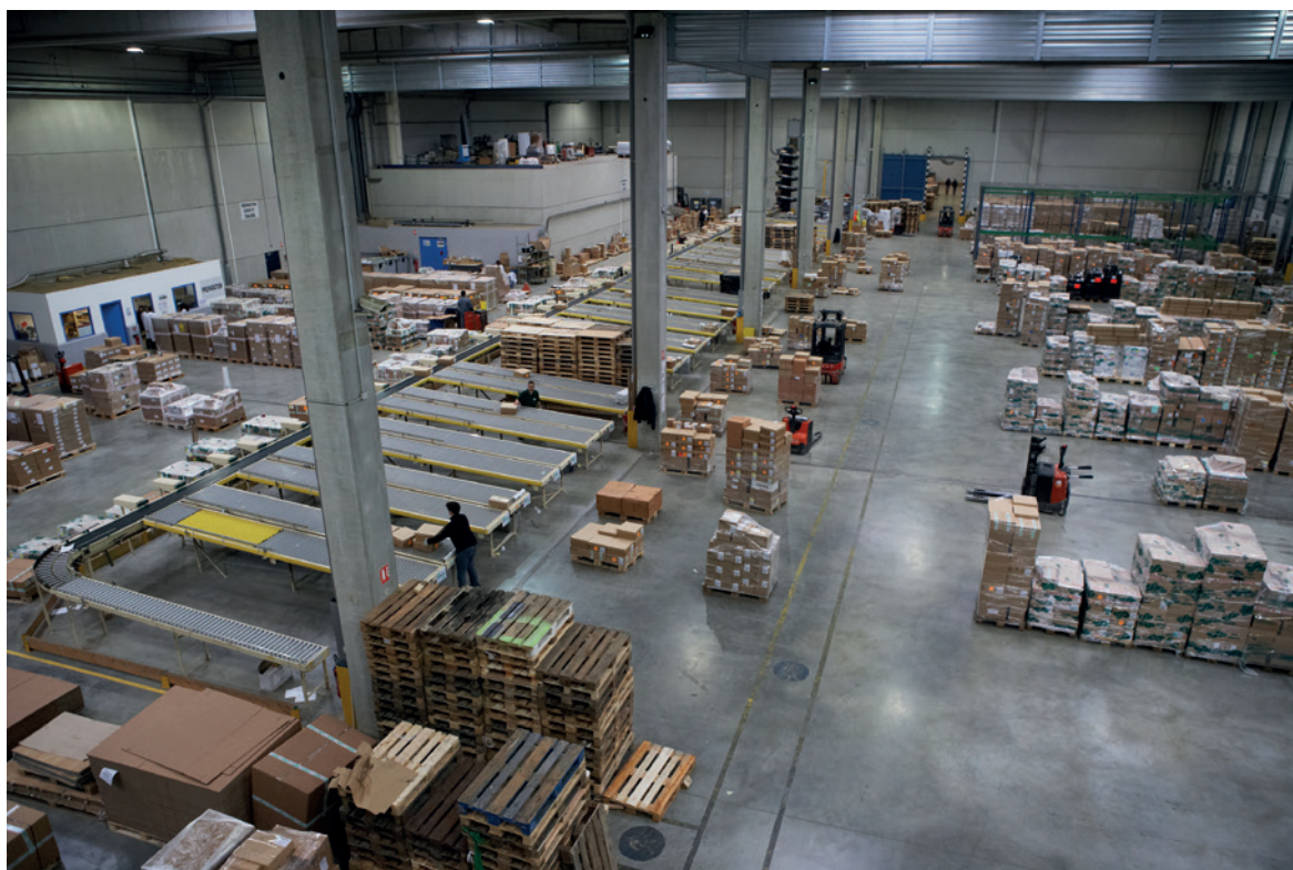
3. Dallage d'une zone de picking dans un bâtiment logistique - (crédit SOREDAL)
