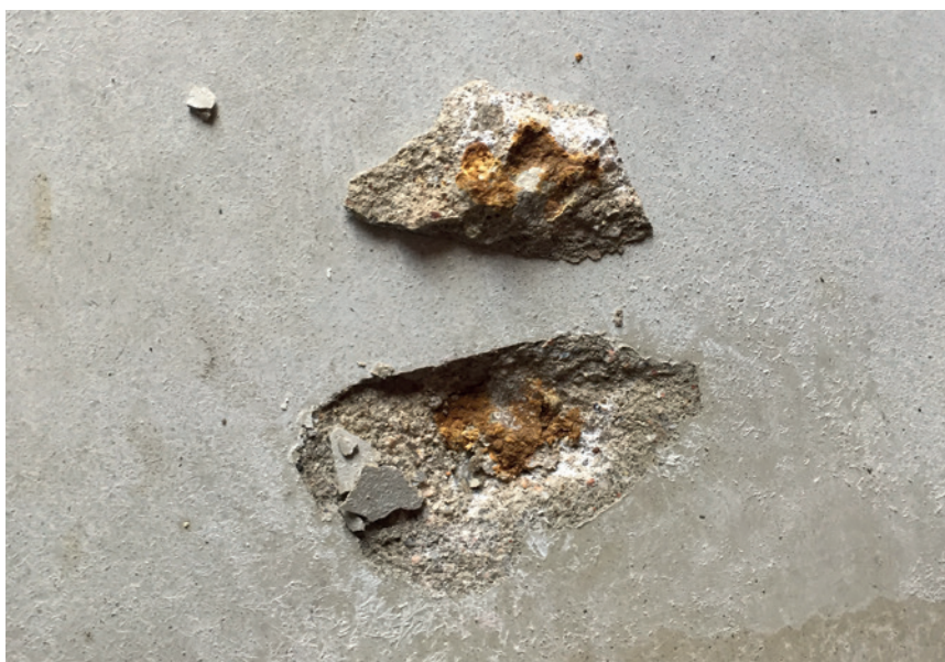
47. Cratère : exemple de manifestation de l'alkali-réaction - (crédit SOCABAT)
