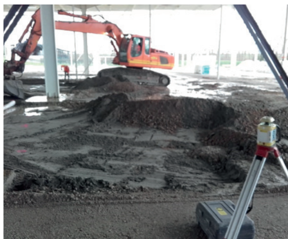
8a et 8b Préparation de la couche de forme (crédit COLAS)
