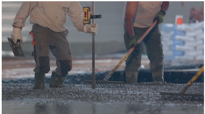
21. Dressage manuel du béton - (crédit SOREDAL)
