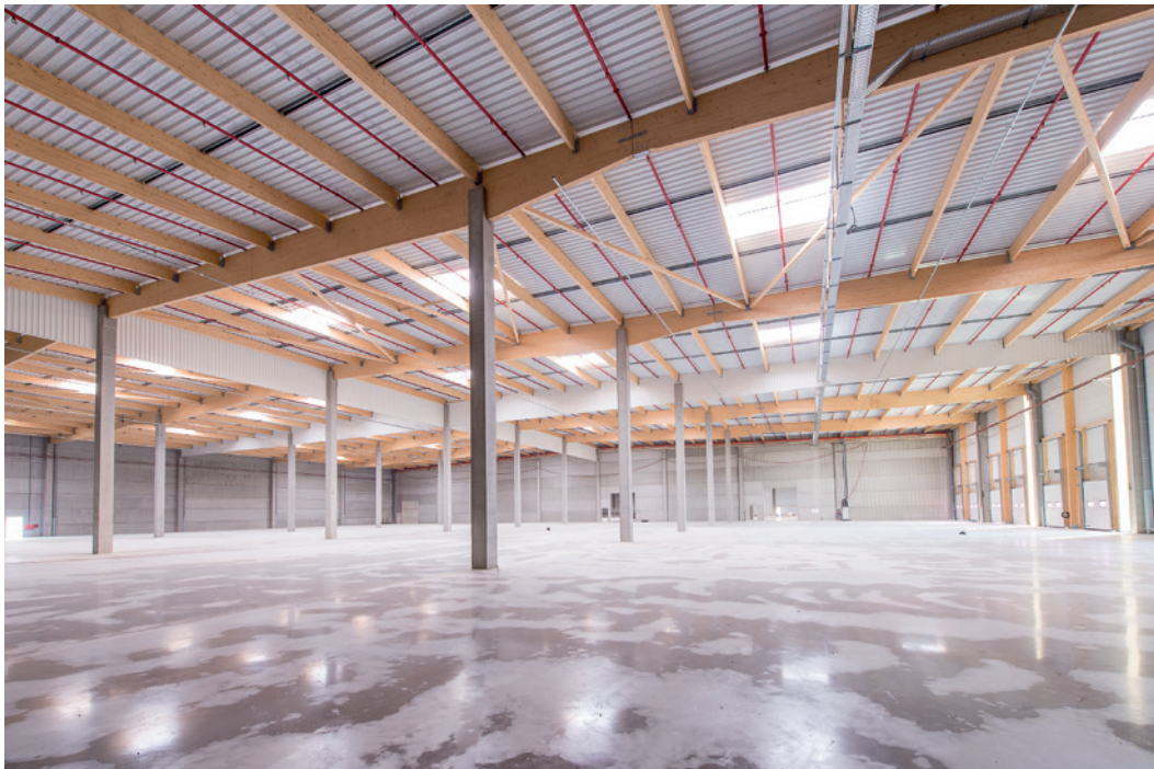
31. Séchage progressif et hétérogène du produit de cure - (crédit SOREDAL)
