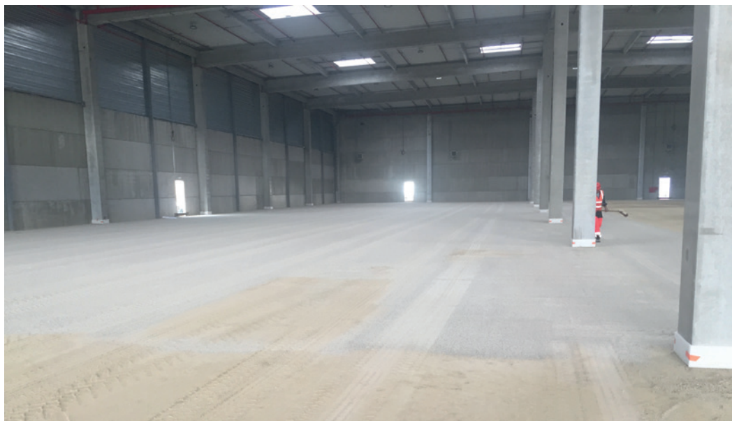
37. Nivellement du sol support - (crédit SOREDAL)
