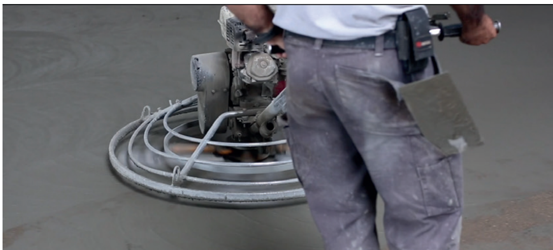
23. Talochage mécanique du béton - (crédit SOREDAL)
