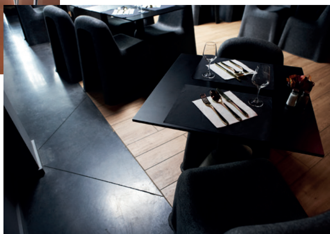
28. Exemples de couches d'usure colorées : a) chamois et b) anthracite - (crédit SOREDAL)
