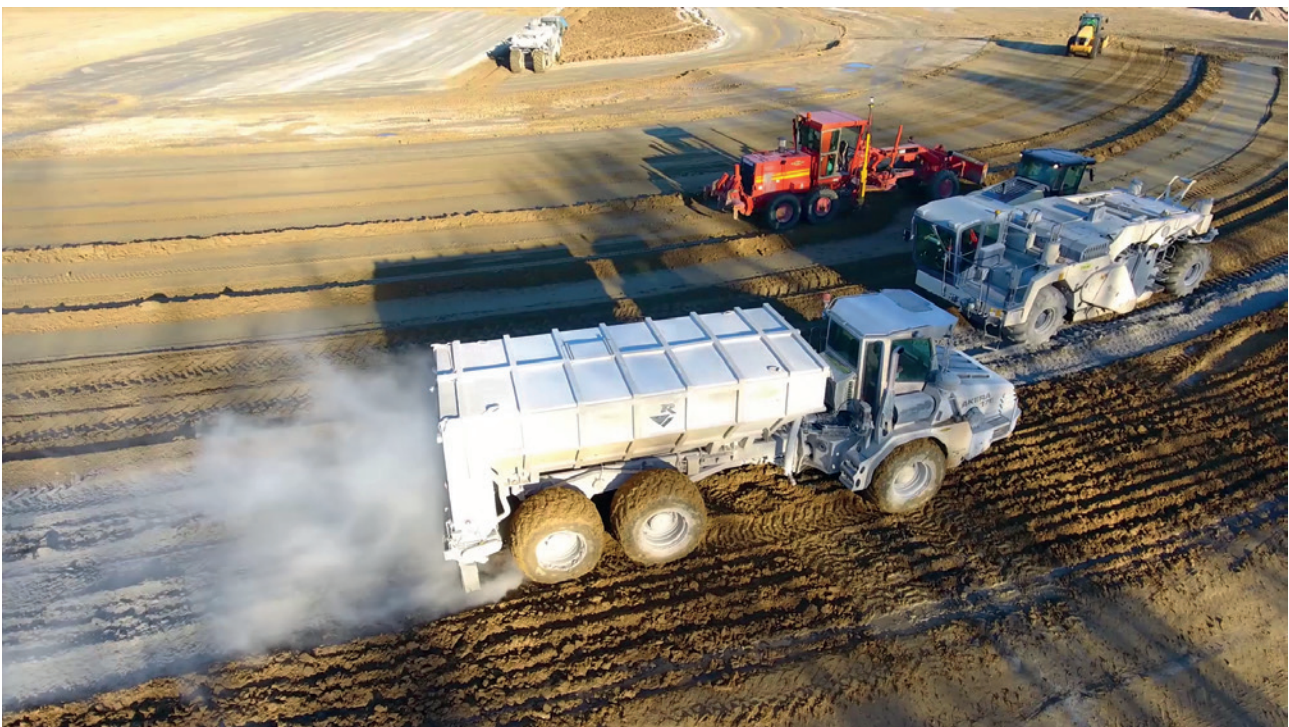
9. Traitement d'une couche de forme aux liants hydrauliques routiers ou au ciment - (crédit COLAS)
