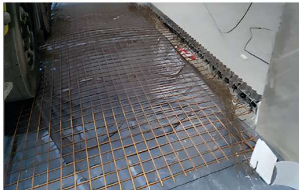
34. Exemples de joint sinusoidal : implantation et livraison - (crédit PLACEO)
