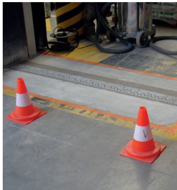
42. Arrêt de coulage réparé (crédit SIFLOOR)
