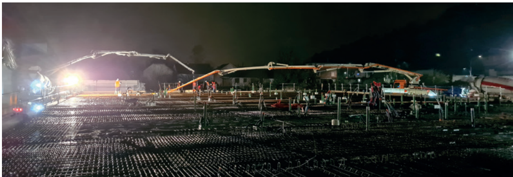
19. Pompage béton de nuit - (crédit SOREDAL)
