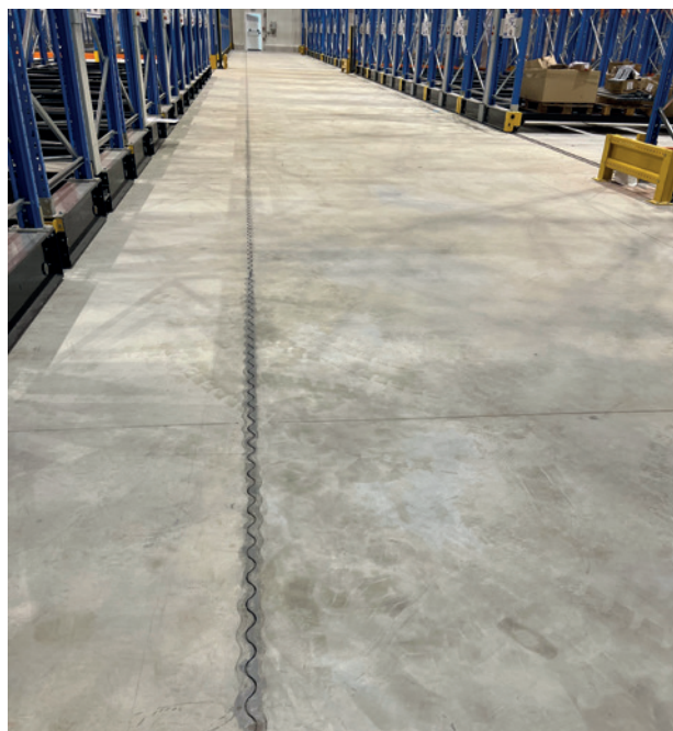
35. Vue de joint sinusoidal - (crédit SOREDAL)
