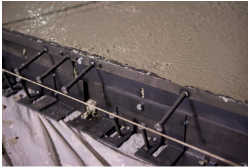
33. Système de joint d'arrêt de coulage (crédit SOREDAL)
