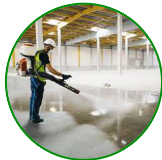
Traitement chimique des poutrelles
