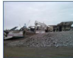
Concassage du béton
