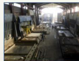
Coulage du béton
