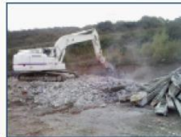
Broyage des poteaux
