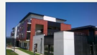
Ouvrage avec Béton Recyclé
